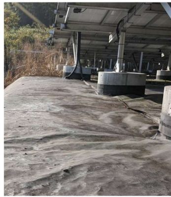
マイティシート (PET樹脂製 設置後10年以上経過)
